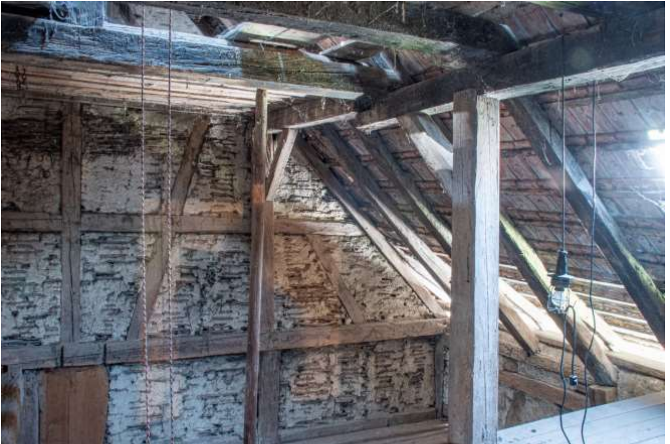
Trennwand zum Nachbargebäude sowie Dach Nordseite (rechts im Bild)
