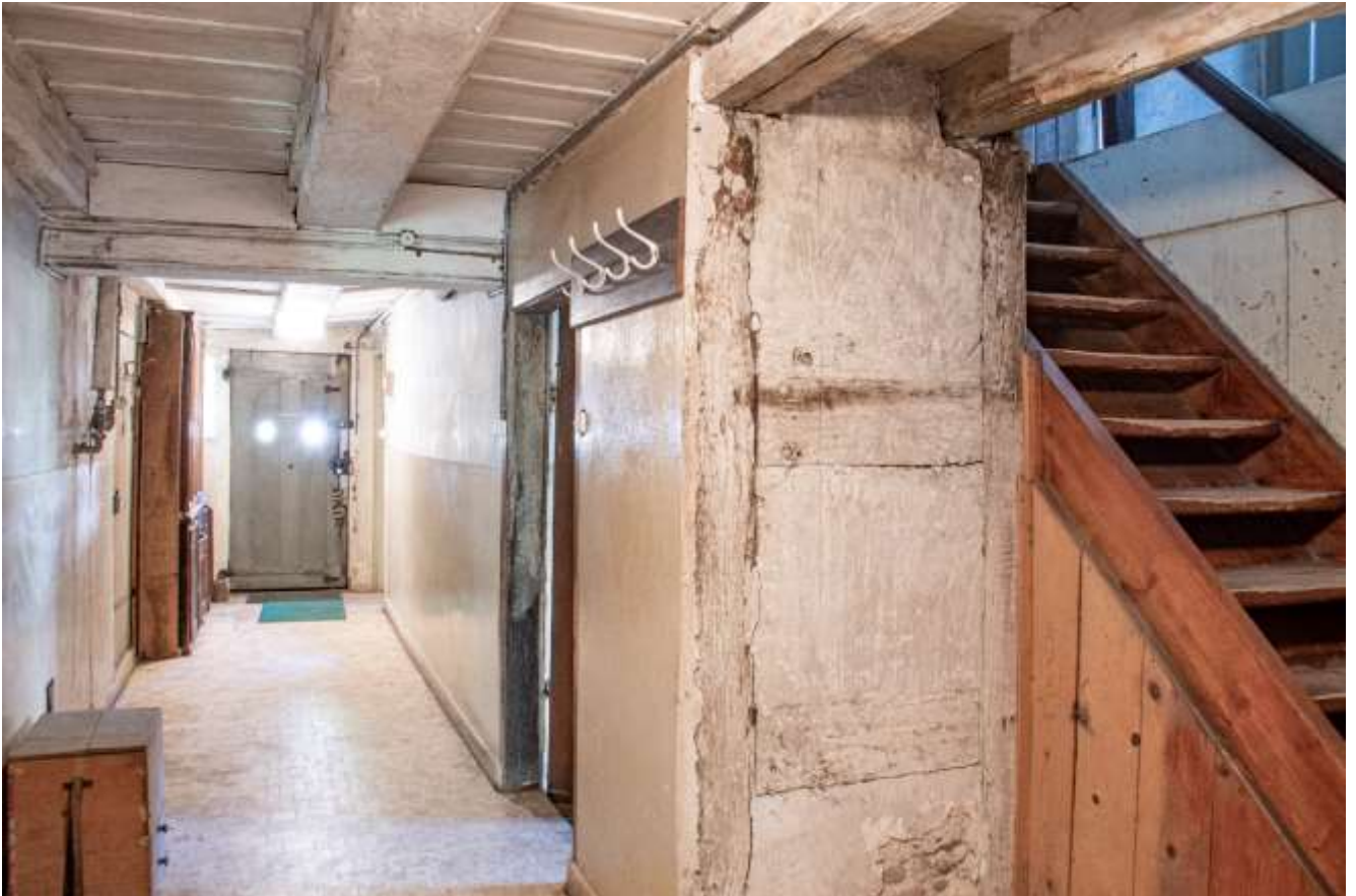
Blick vom Eingang Süd zum Haupteingang Mitteldorf, Treppe ins OG rechts
