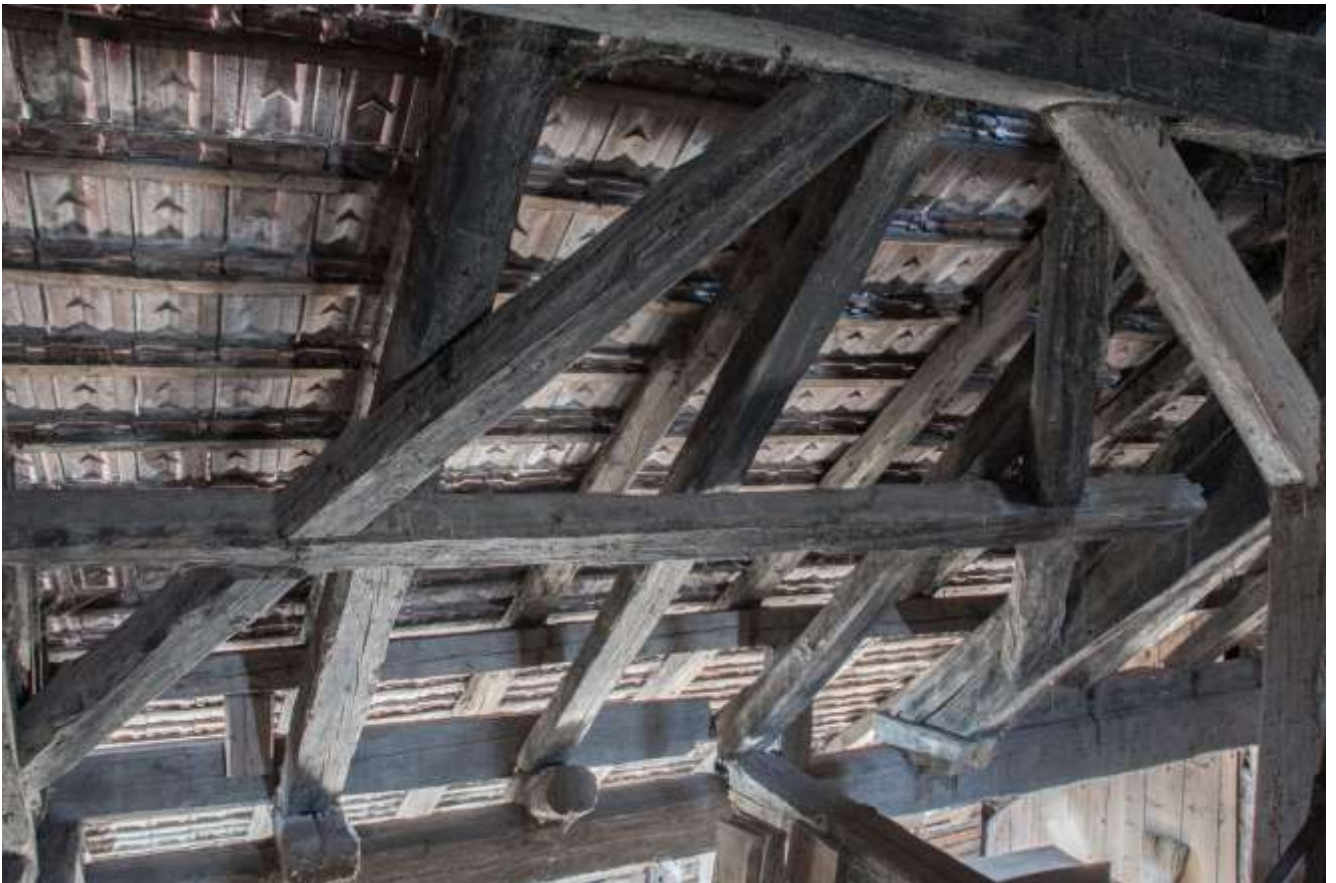
Teile der Dachkonstruktion (Südseite)
