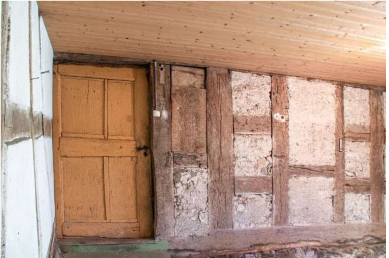
Eingang Süd vom Zwischenbau
